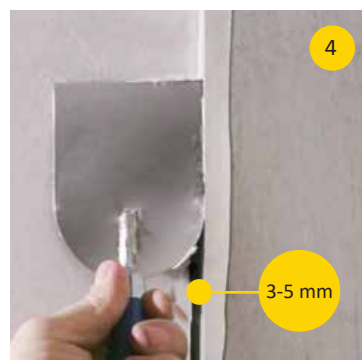
4. Die Fugen fachgerecht verspachteln.
