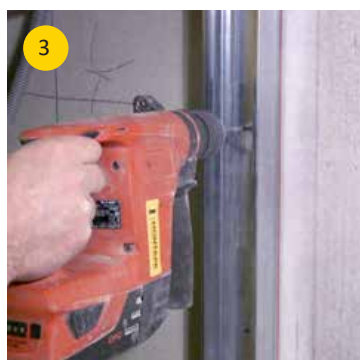
3. Das Profil befestigen und Gipskartonplatte montieren.
