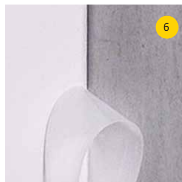
6. Mangelfreie norm- und herstellerebene Anschlussfuge.
