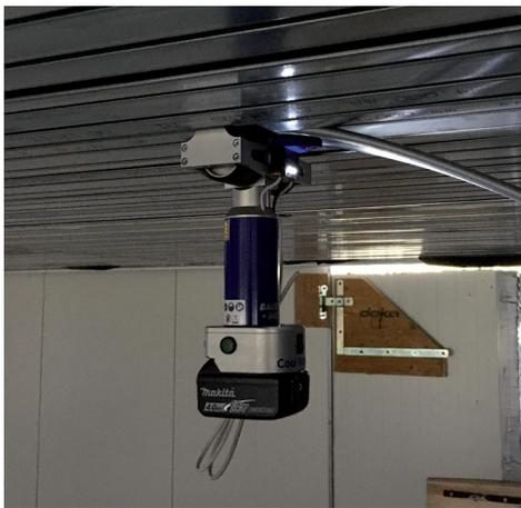
9. Nach der Bogenherstellung und dem Vorklemmen am nächsten Profil wird die Maschine entlang des Rohrbogens geschwenkt und am nächsten Profil eingehängt. Ein Abnehmen des Einpresswagens von der Decke ist nicht nötig.
