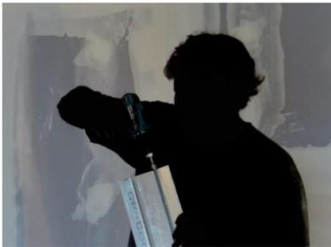
4. Die Systemrohre sind nun von der Raumseite zu Beginn der einzelnen Profile in die dafür vorgesehenen Kanäle zu führen, wobei ein Überstand entsprechend dem Abstand zum Anschlussstück + 10cm zu wählen ist. Durch Anheben der Profiflügel kann jedes Rohr im Rohrkanal eingeklemmt werden.
