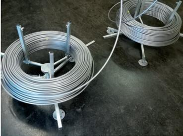
1. Zwei Registerrohrrollen in die Abrollvorrichtung einlegen und zentral im Raum positionieren.
