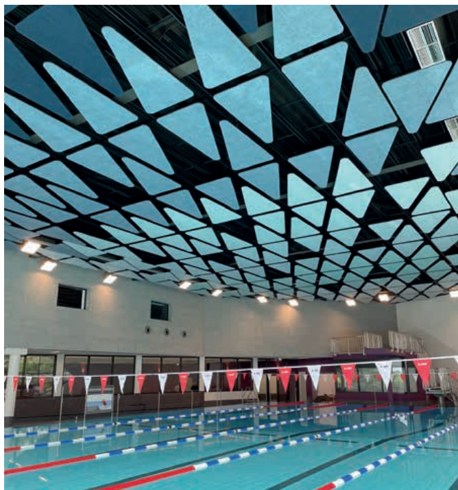
Schwimmbad Düsseldorf/Oberkassel – Montage von: ca. 3.000 qm Gipskartonplatten, 2.000 qm Aquaplaten, 2.000 qm Holzwoledecken, 1.000 qm Akustikdecken/Mineralfaser, 250 Stk. Sondersegel aus Holzwole, 120 Stk. Alu-Zargen und Türblätter sowie diverse andere Sonderbauteile.
