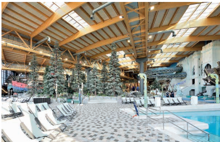
Europa-Park Rust – Montage von: ca. 5.000 qm Holzwohle-Akustikdecken, 6.500 qm Aquapanel-Platten Verarbeitung an Torbögen, Metallständerwänden, Vorsatzschalen und Sonder-Wolkendecken.
