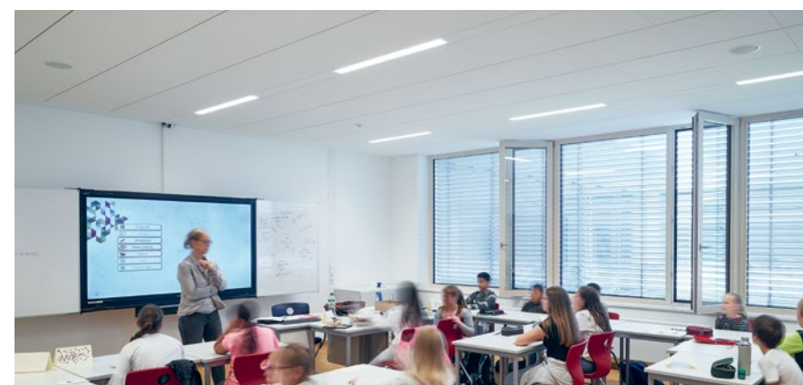
In Klassenzimmern und Aufenthaltsräumen der Oberschule Artland wurden Ecophon Akustikdecken montiert, um die Konzentrationsfähigkeit und Sprachverständlichkeit zu verbessern. (Foto : Christian Wese)
